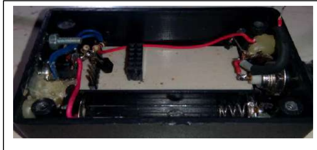
Gambar 8. Mainboard yang sudah terpasang di wadah.
